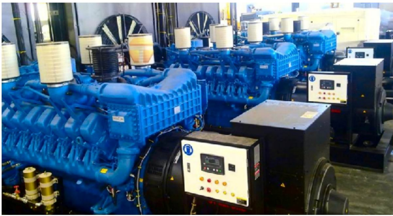
3 Unit MTU 16V 4000 G63 2000 kVA – Project SDC Summarecon
